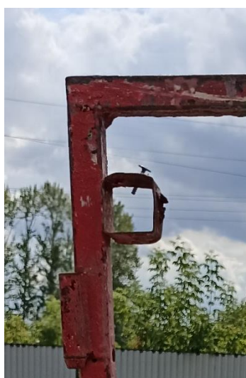
Рис. 9 Гнездо крепления съемного поручня
